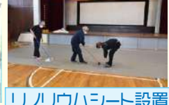
リノリウムシート設置
