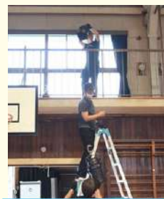
照明機材の設置
